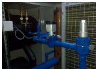
Vanne d'arrêt avec capuchon à droite et actuateur motoriser à gauche
