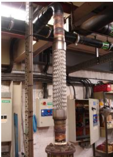
Dispositif anti vibratoire mal installé
